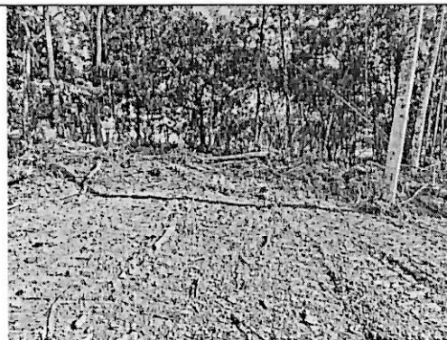
Foto 4. Individuos forestales removidos del suelo con maquinaria pesada y apilados a los costados de la vía.
