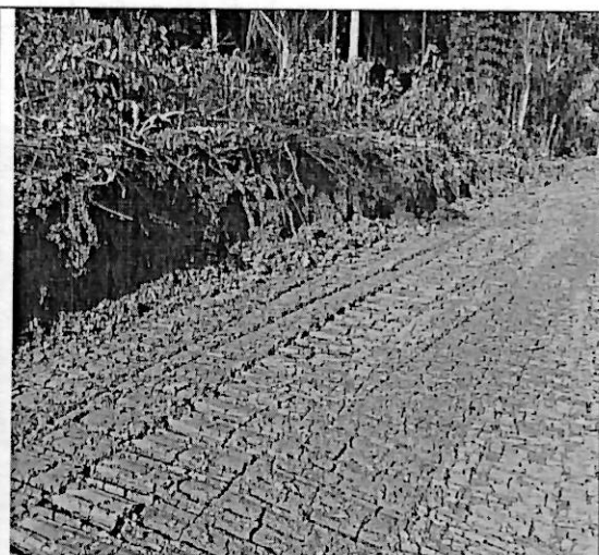
Foto 6: Construcción de acceso terrestre con maquinaria pesada. Material compacto y seco.
