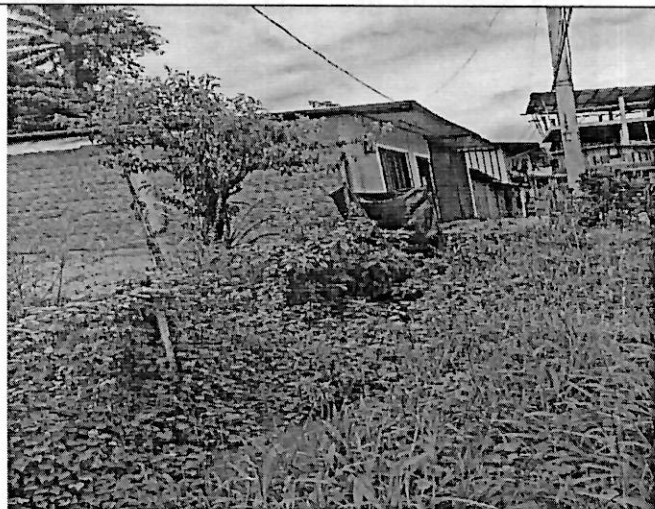
Foto 2. Evidencia de un espejo de agua sobre la margen del cauce afectado por la construcción de viviendas
