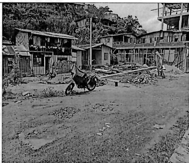
Foto 7. Viviendas construidas en los alrededores de la fuente hídrica.
