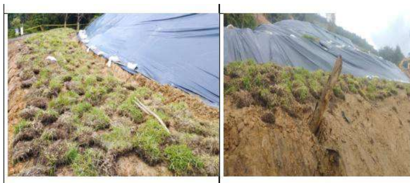
Foto. Labores de empradización
