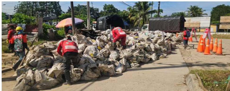
Imagen. Equipo realizando descolmatación y retiro de residuos
