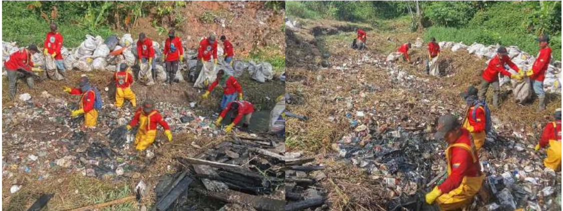
Imagen. Equipo realizando descolmatación y retiro de residuos
