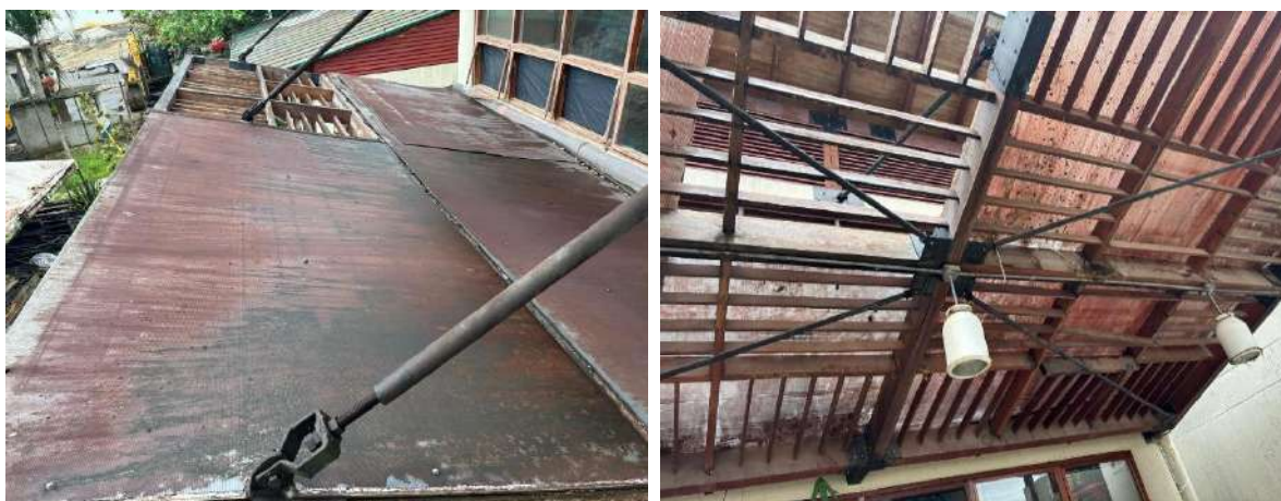
Fotografías. cubierta del techo antes de la adecuación
