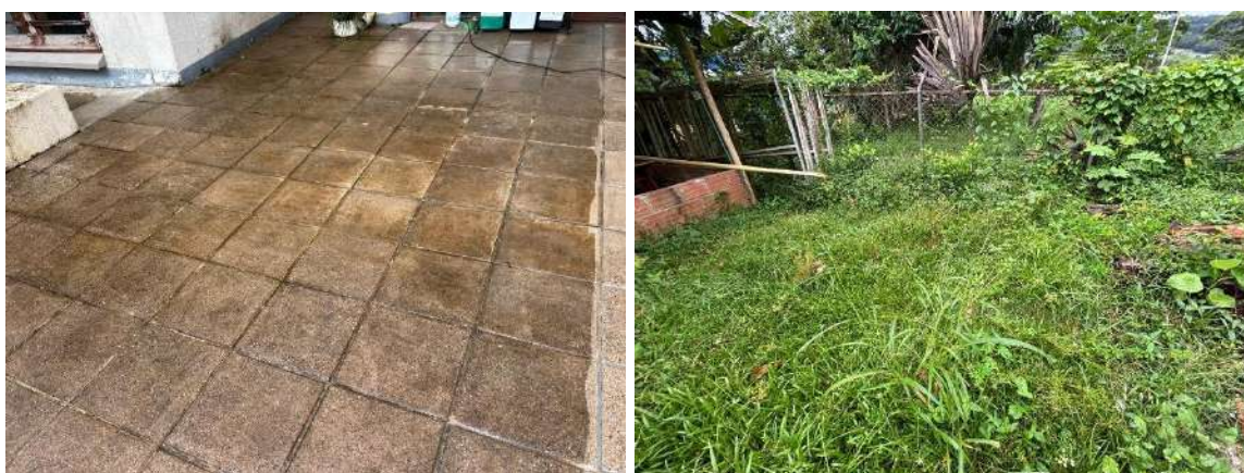
Foto. Pasillo de ingreso antes de la adecuación
