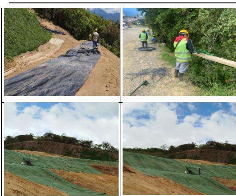
Foto. instalación de geo sintético para el control de erosión, Municipio de Sibundoy (Putumayo)
