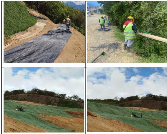
Fotografía. instalación de geo sintético para el control de erosión, Municipio de Sibundoy (Putumayo)
